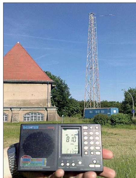
Über die von diesem 35-m-Turm wegführende T-Antenne sendete welle370 auf 810 kHz.
