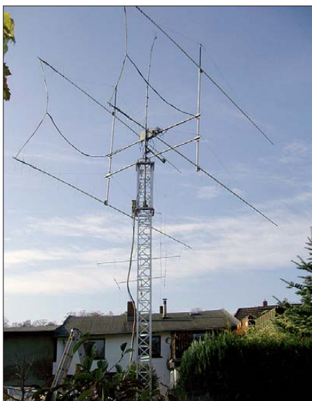
Die 4 × 14-Element-Kreuz-Yagi-Antennen bei Jo, DL9MS, in JO54WC – umschaltbare Polarisation von horizontal auf vertikal sowie zirkular sind möglich. Foto: DL9MS
